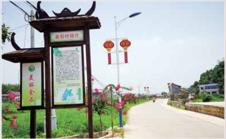
去年，衡山县新建和改造农村公路 100 公里，自然村通水泥路实现全覆盖
