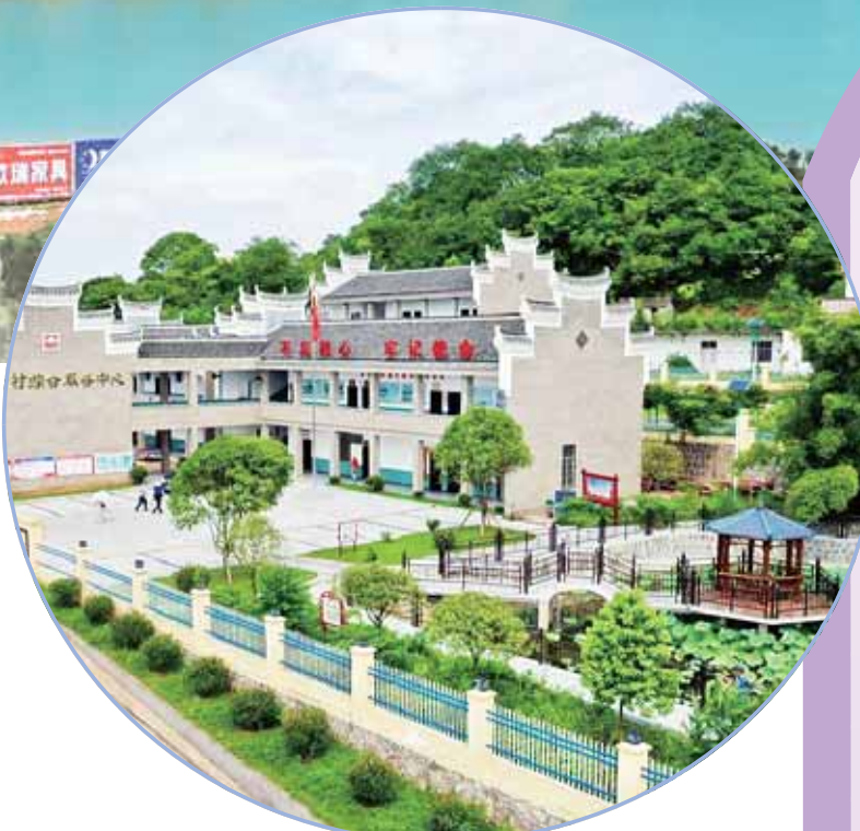
美丽乡村建设成效凸显,图为六合村综合服务中心
