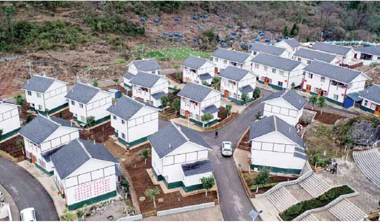
2月3日拍摄的化屋村麻窝寨易地扶贫搬迁集中安置点。 春节临近,地处乌蒙山腹地、三岔河畔的贵州毕节市黔西县新仁苗族乡化屋村洋溢着喜庆的气氛。 化屋村过去叫“化屋基”,意为“悬崖下的村寨”。这里山势雄奇,水域宽广,风景如画,被誉为“乌江源百里画廊”。近年来,化屋村在精准扶贫推动下,迎来跨越式发展。依山就势的移民新村拔地而起,平坦干净的通组串户路直通家门。2017年,化屋村实现脱贫摘帽,这个昔日贫困发生率高达66.3%的少数民族村寨旧貌换新颜。化屋村的变迁史,也正是我国少数民族地区脱贫历程的一个生动缩影。 ■新华社发
