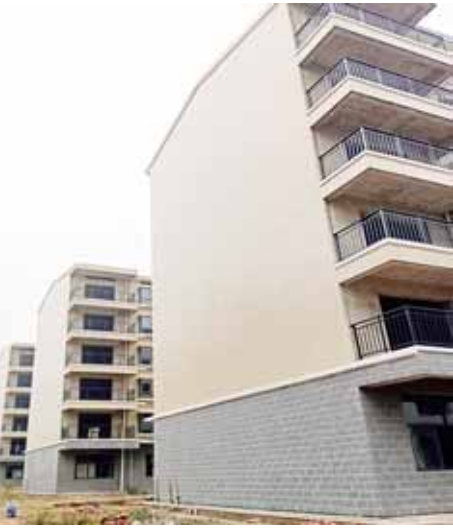
新民安置小区南片区
