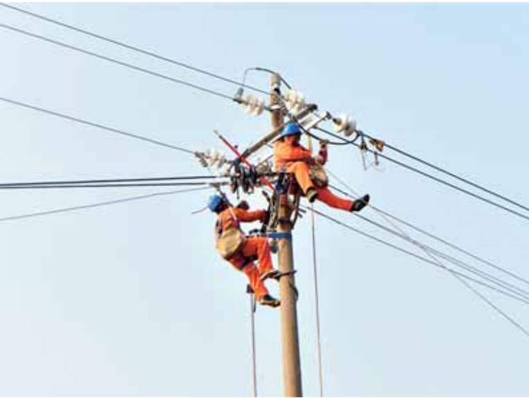
常宁供电公司工人正在进行电网改造作业
