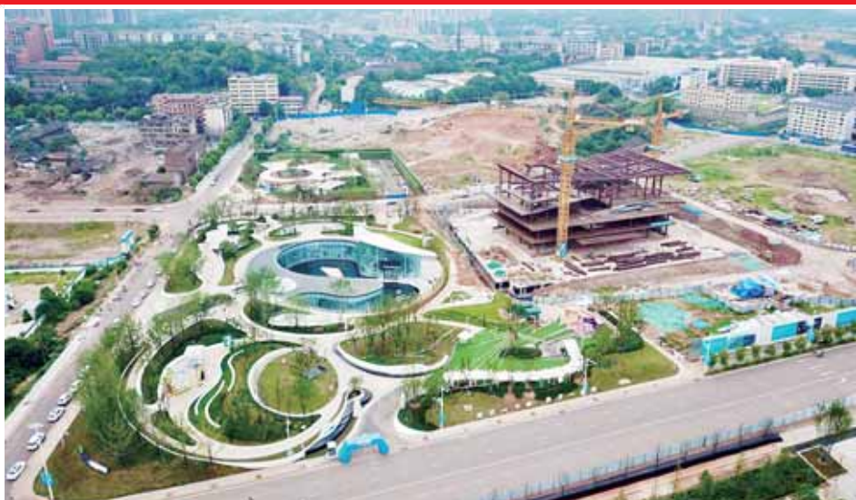
华侨城项目建设现场
