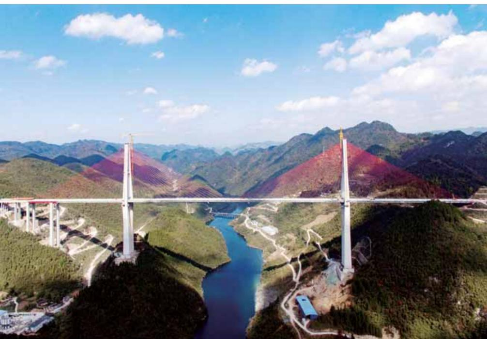
建设中的遵余高速湘江大桥(无人机照片,11月16日摄)。12月3日,由中铁广州局承建的贵州遵(遵)余(余庆)高速重点控制性工程湘江大桥顺利实现贯通,为遵余高速全线建成奠定了坚实的基础。遵余高速湘江大桥桥梁全长1700余米,主跨560米。 ■新华社发
