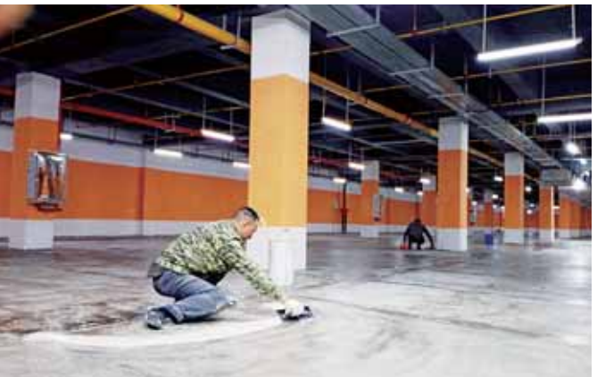
地下停车场环氧地坪漆施工
