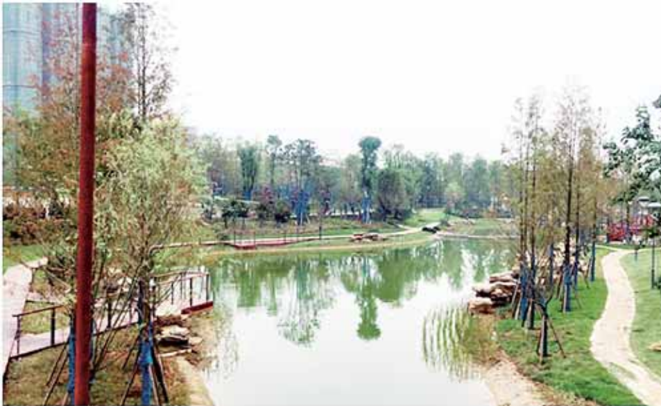
南区公园（施工方供图）
