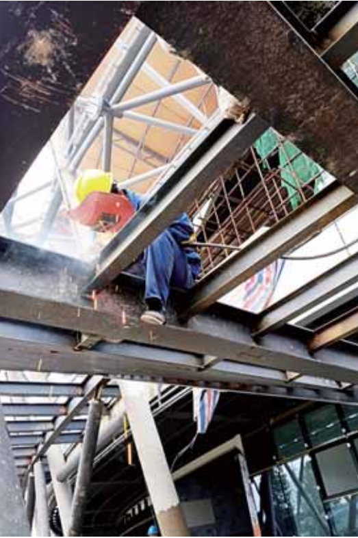
焊接钢结构楼梯
