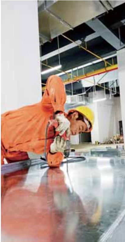
防排烟管道制作安装
