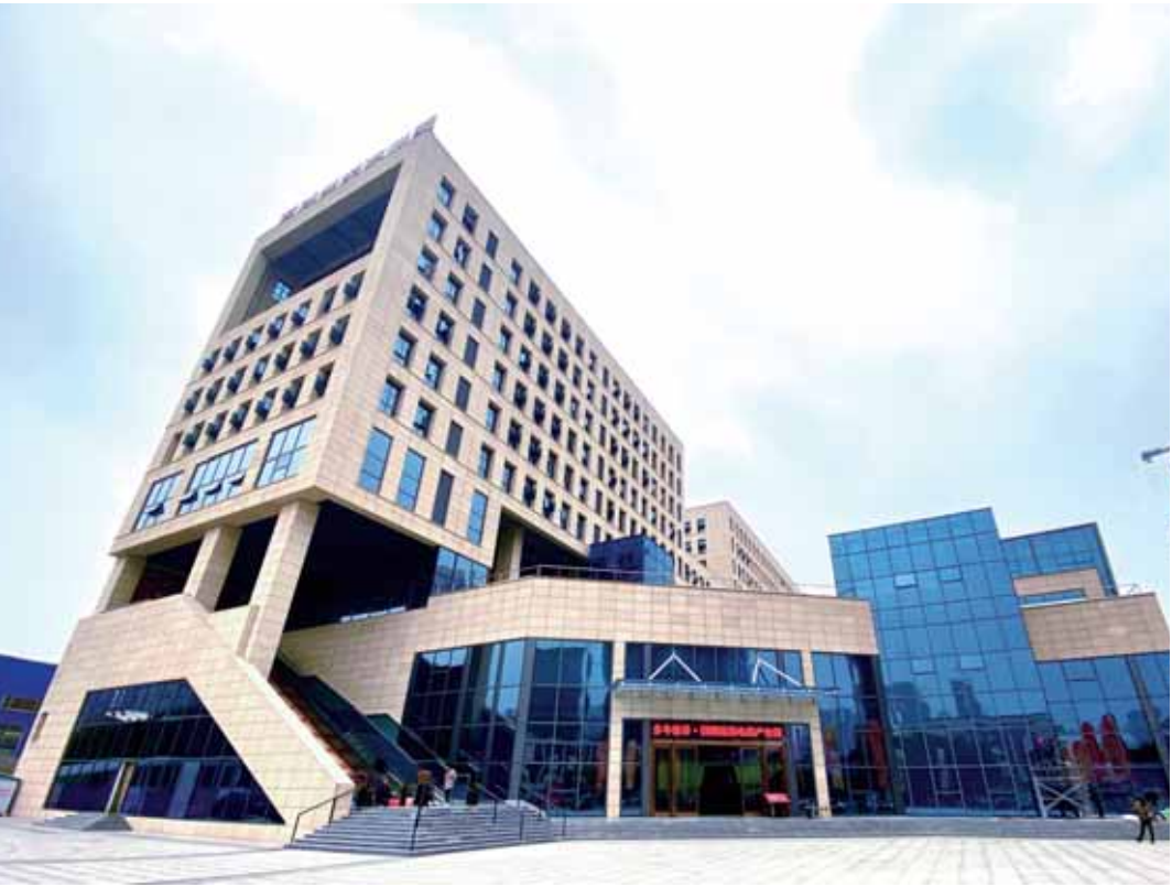
高新电商产业园
