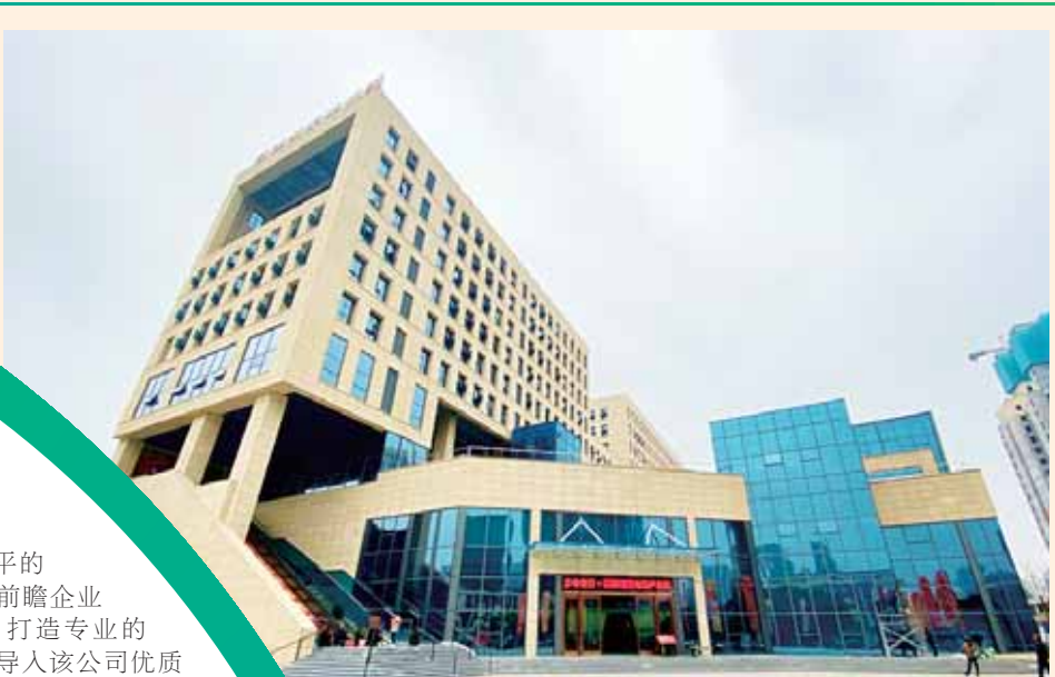
高新电商产业园
