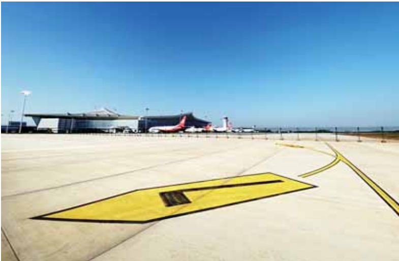
南岳机场站坪扩建工程
