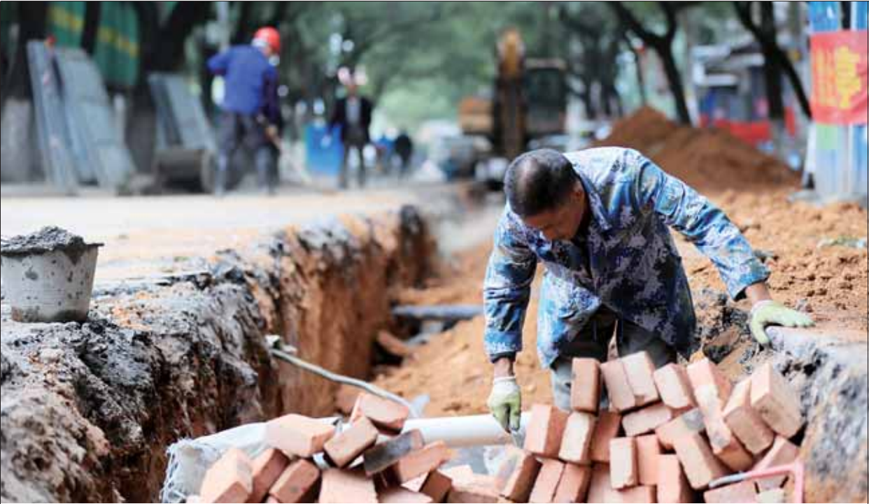
10月20日，工人正在对珠晖区冶金街道进行地下管线改造施工。近年来，珠晖区充分利用原中央下放企业职工家属区“三供一业”分离移交中央财政补助资金，对衡治家属片区足球场、建筑立面、景观园林、水、电、气供给系统等进行改造提质，为改善片区居民生活环境奠定了良好基础。
