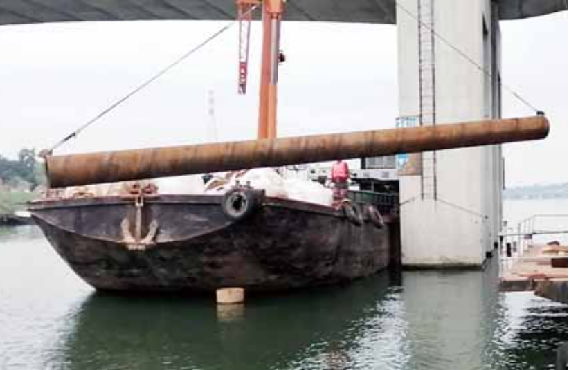
安装桥梁防撞设施
