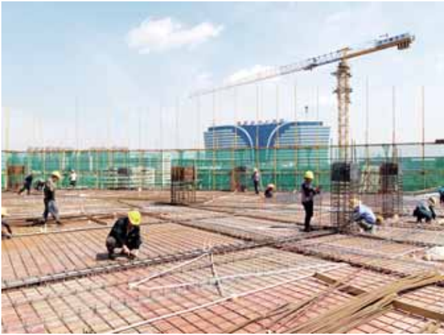
施工现场热火朝天
