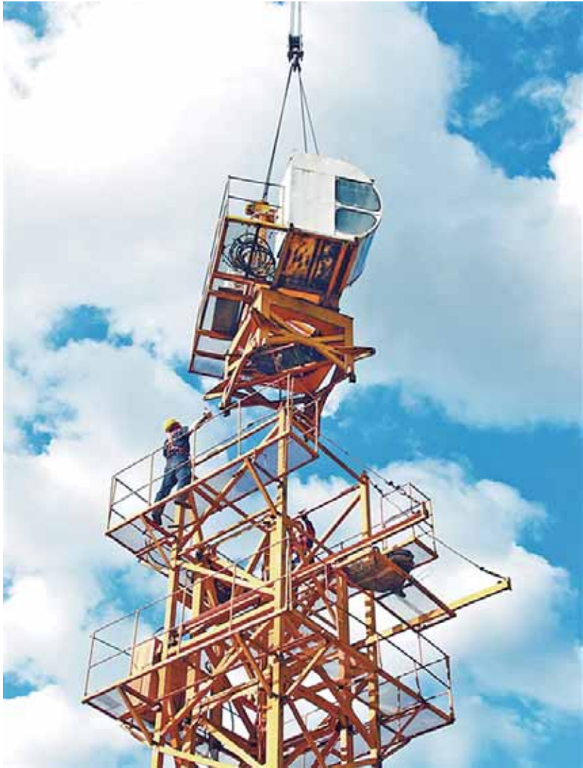
8月3日，湖南省永州市江永县建设工地，中铁十七局建筑工人在高空安装塔吊。按照高质量发展要求，不少企业不断在提高供给质量上下功夫，进一步巩固国内市场，降低外部冲击带来的压力。
