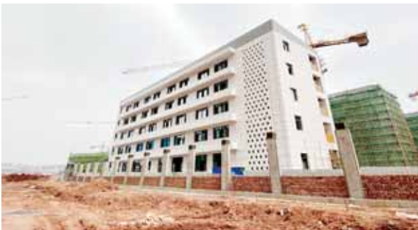
部分教学楼外墙已装修好
