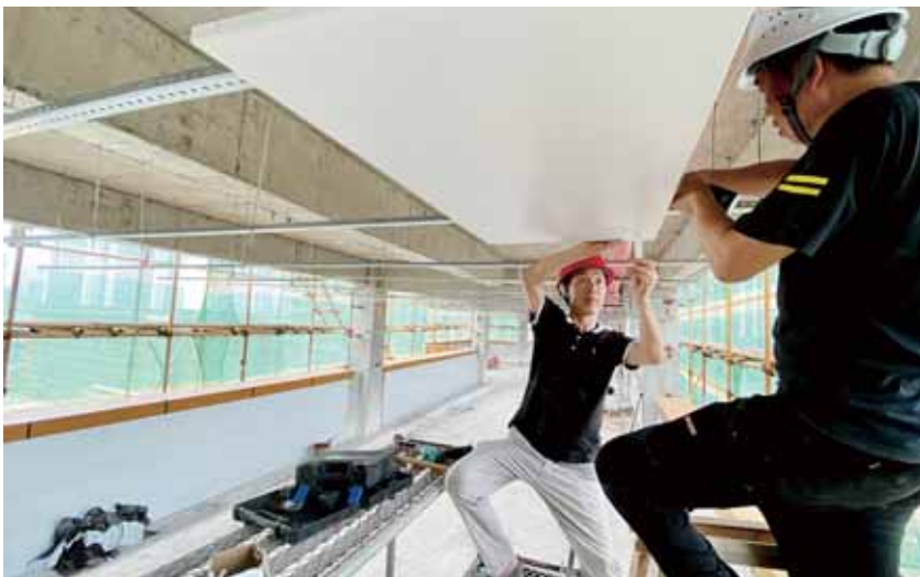
工作人员正在吊顶
