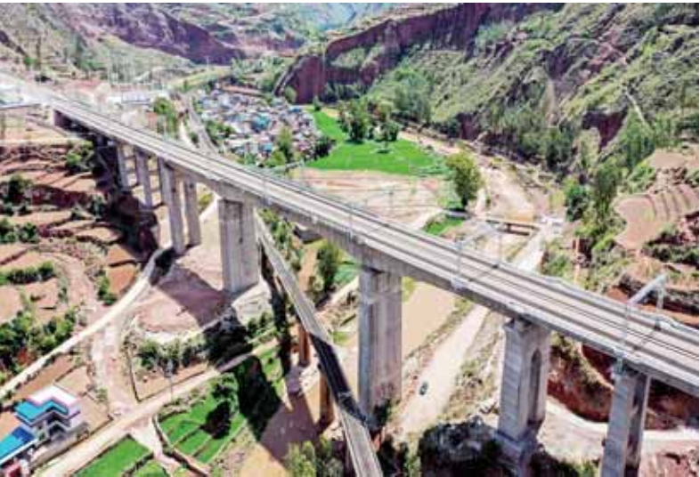
这是采用“转体施工法”建设的大树村龙川江三线大桥(上)一景,该桥单体转体重量 7350 吨,总重量 14700 吨(无人机照片,6 月 23 日摄)。
