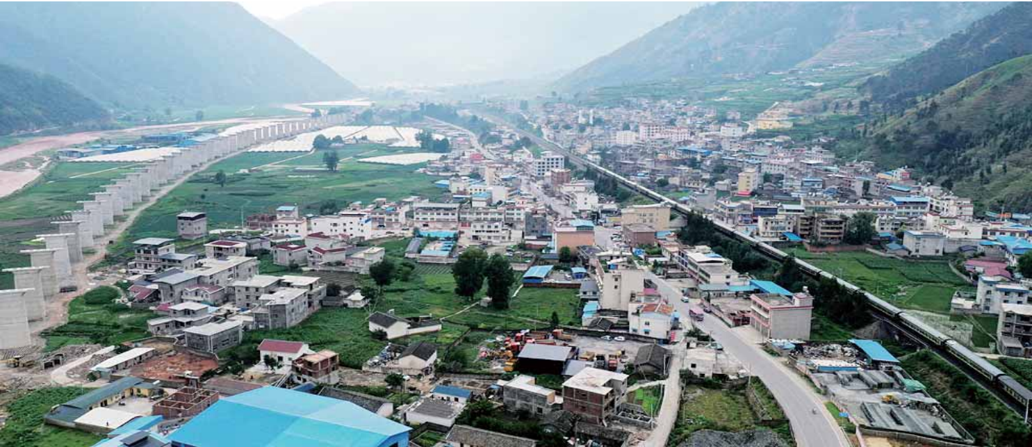
一辆列车行驶在成昆铁路四川省凉山州喜德县境内,旁边就是正在建设中的新成昆铁路(无人机照片,6 月 21 日摄)。
