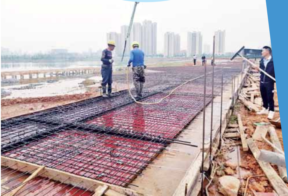
云水别岸进行模板施水
