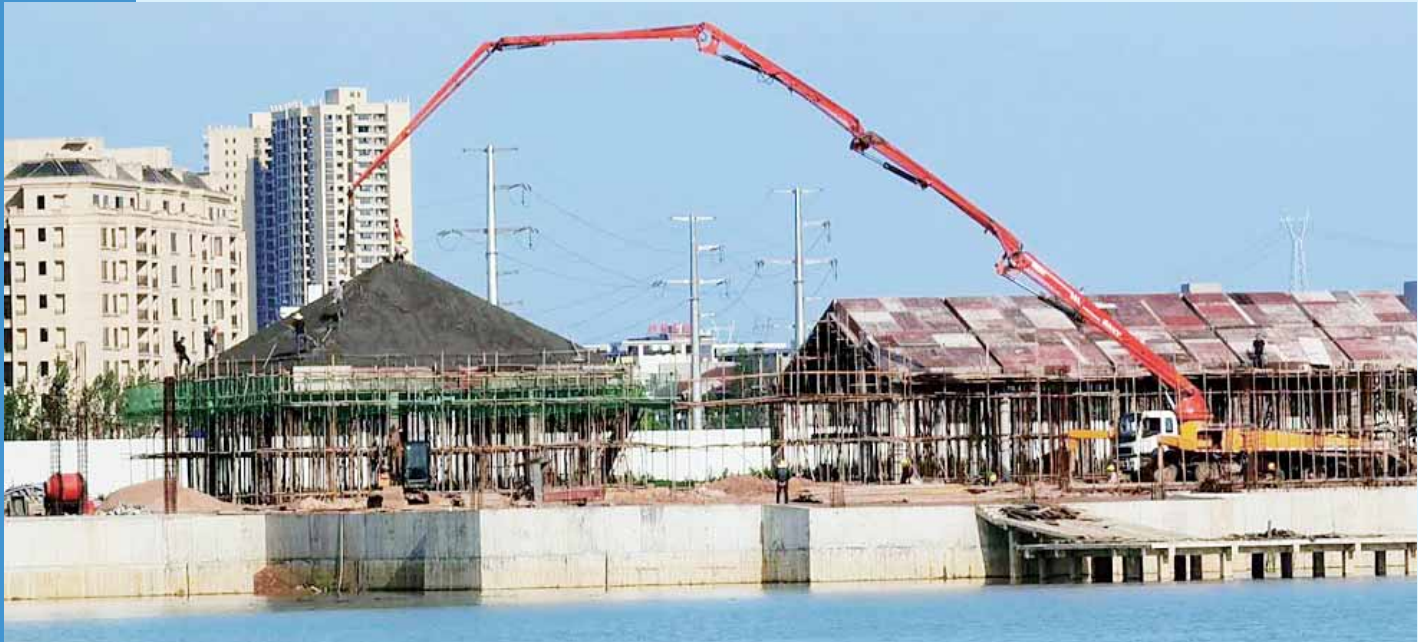
汉风古韵浇筑施工
