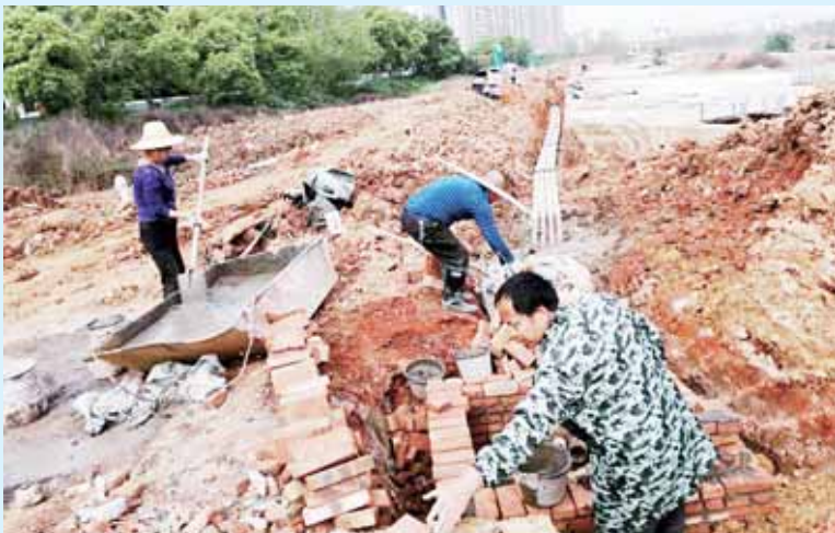
烟波万里管网施工
