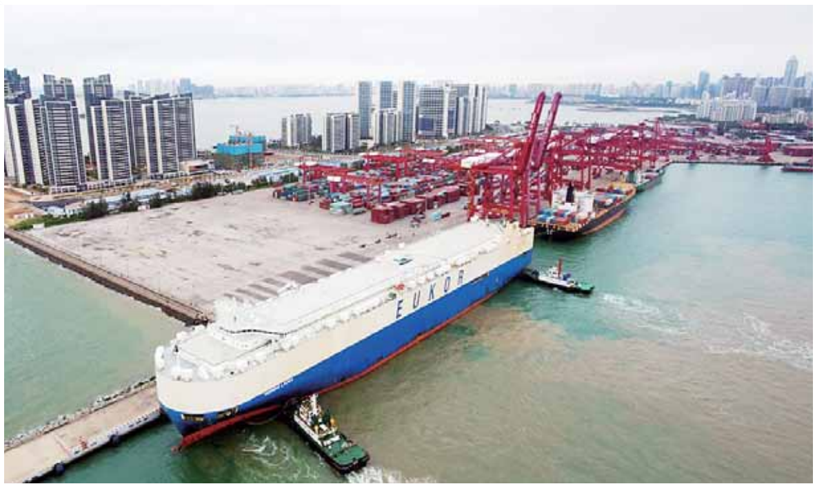
▲滚装货船“劳拉”轮驶入海口秀英港，这是海南自贸区政策实施以来的首艘汽车外贸船（2月16日摄，无人机照片）。 ▲这是4月4日拍摄的三亚亚特兰蒂斯度假区（无人机照片）。
