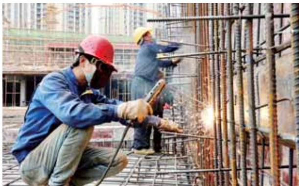
2月27日，雁鸣溪小学建设工地上工人正在加紧施工。 ■周围 摄
