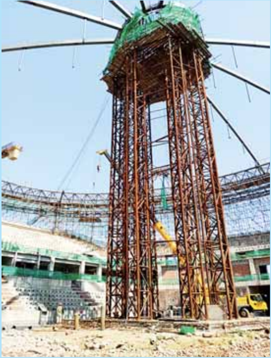
中心球场钢结构施工
