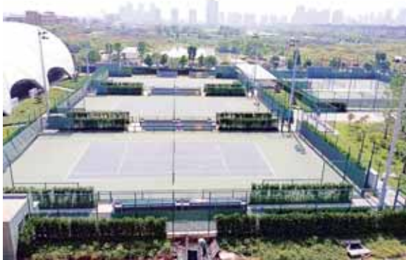
网球场, 除中心球场外, 其他部分均已竣工
