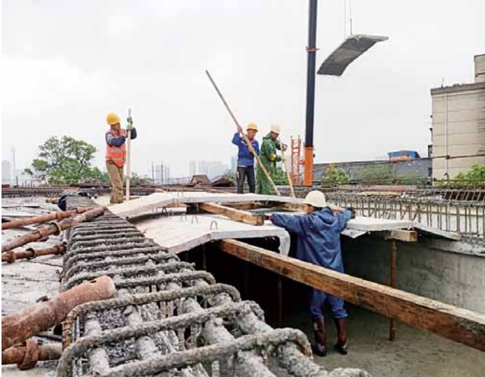
工人安装微弯板
