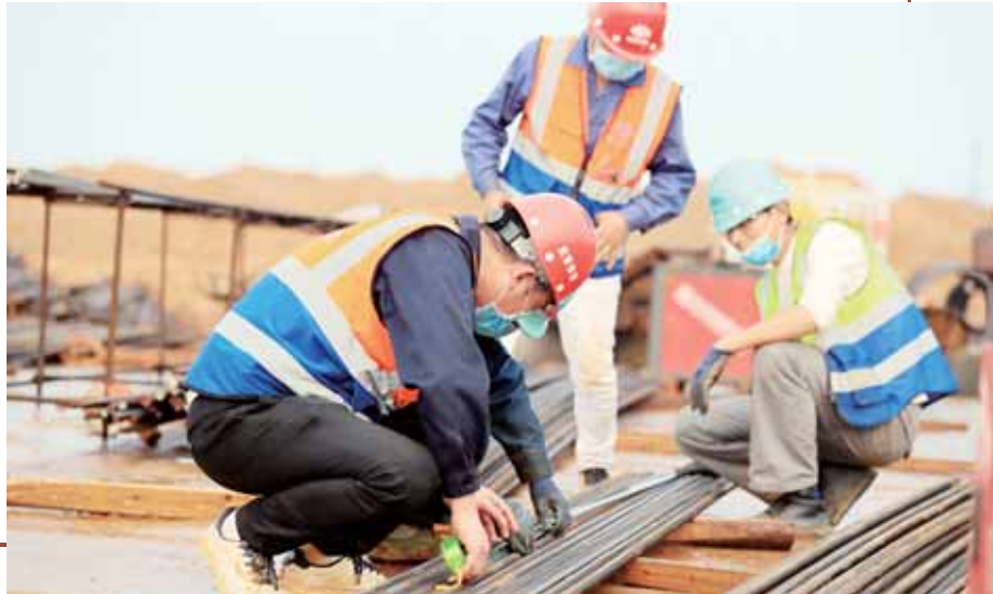
湖南雁翔湘实业有限公司年产1200万重量箱超白光伏玻璃、超薄电子玻璃项目建设现场一派繁忙
