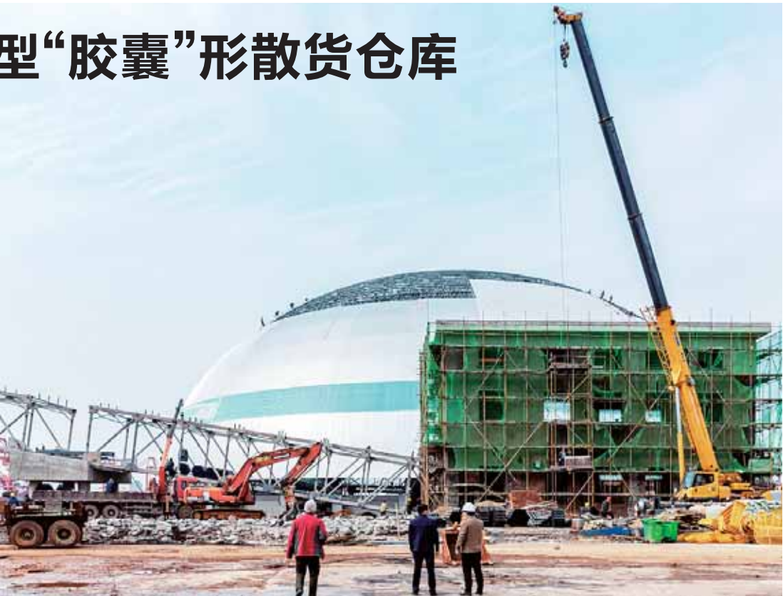
湖南岳阳全封闭「胶囊」形散货大棚在进行封顶作业 ■ 新华社发
