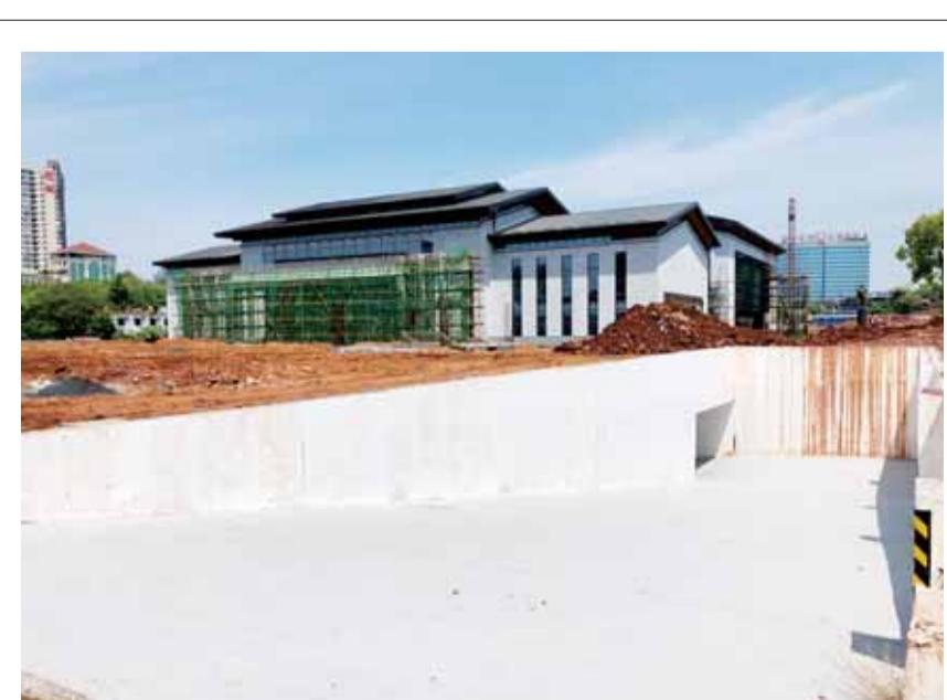
4月13日，衡阳市图书馆项目建设现场，工人们正在进行室内装修、室外绿化及附属工程的施工。含540个泊位的地下停车场已全部完工，等待验收。据了解，该项目主体结构、屋面结构及防水、外立面装饰、24小时图书馆（样板间）等工程已完工，全部预留预埋及工艺管道敷设已完成75%，附属工程结构施工及土方回填已完成70%。预计10月完成建设并交付使用。
