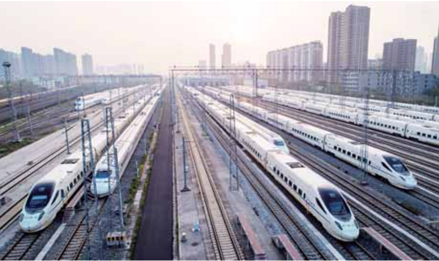
4月8日,在武汉动车段,列车停靠在存车线上准备投入运行(无人机照片)。 ■新华社发
