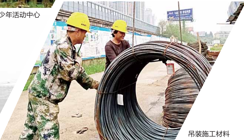
吊装施工材料
