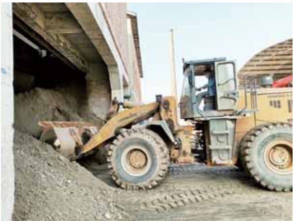
工人正在处理堆积如山的尾砂
