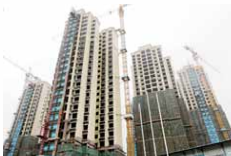
华侨城来雁新城松梅金雁棚户改造项目 主体完成
