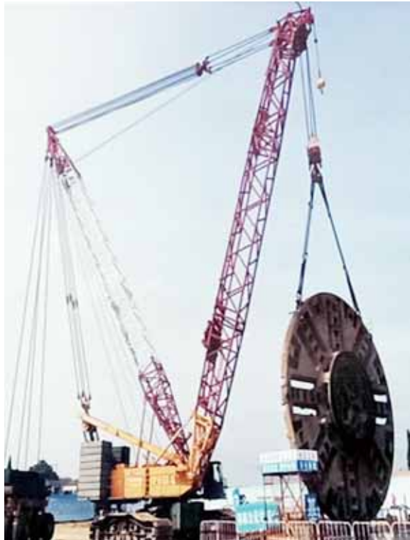
北线盾构机拼装刀盘吊装下井
