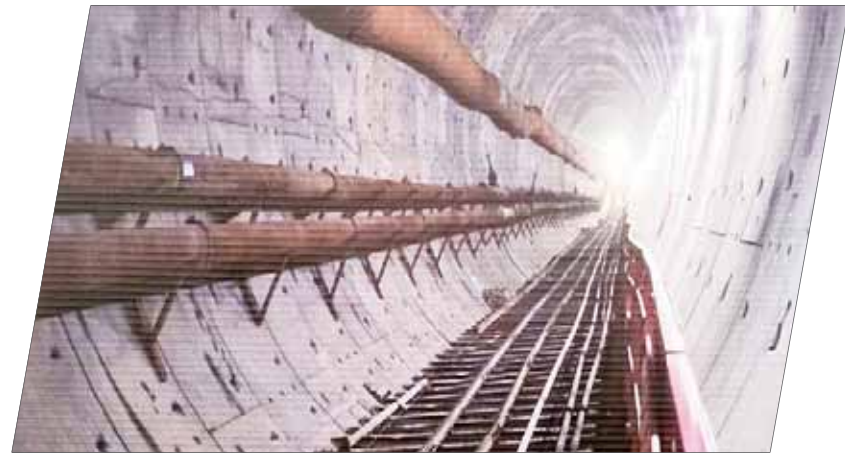
南线盾构机刀盘通过溶洞区
