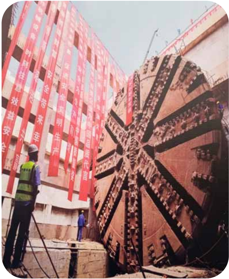
南线盾构隧道贯通
