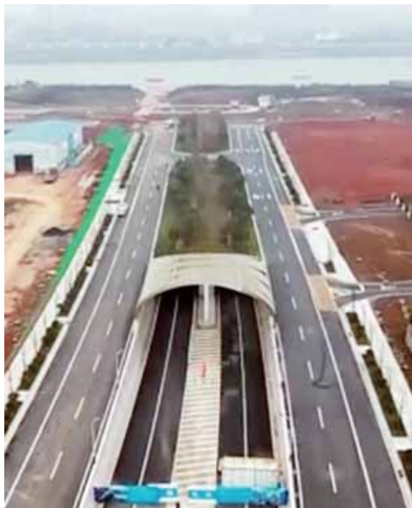
俯瞰合江套隧道
