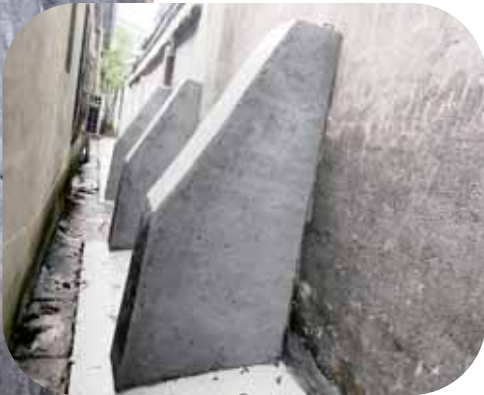
▼三个护墩墩牢牢“顶撑”着倾斜的危墙
