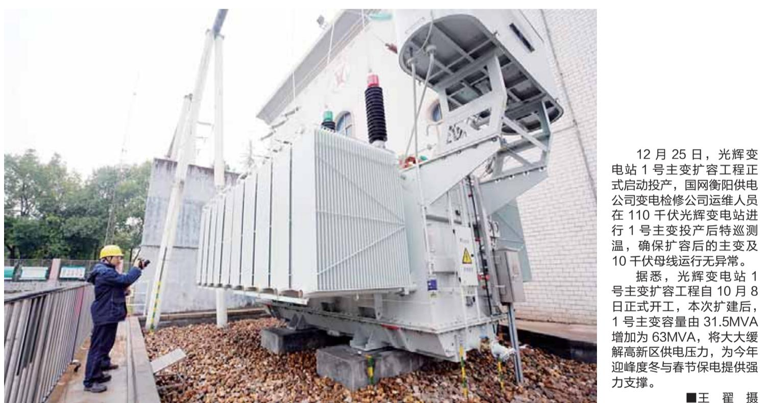
12月25日,光辉变电站1号主变扩容工程正式启动投产,国网衡阳供电公司变电检修公司运维人员在110千伏光辉变电站进行1号主变投产后特巡测温,确保扩容后的主变及10千伏母线运行无异常。
