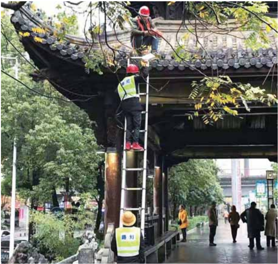
加紧对亮化设施检修维护
