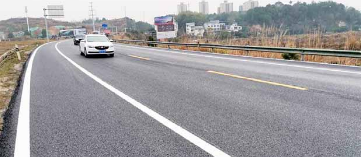
油化完工后的公路“颜值”更高
