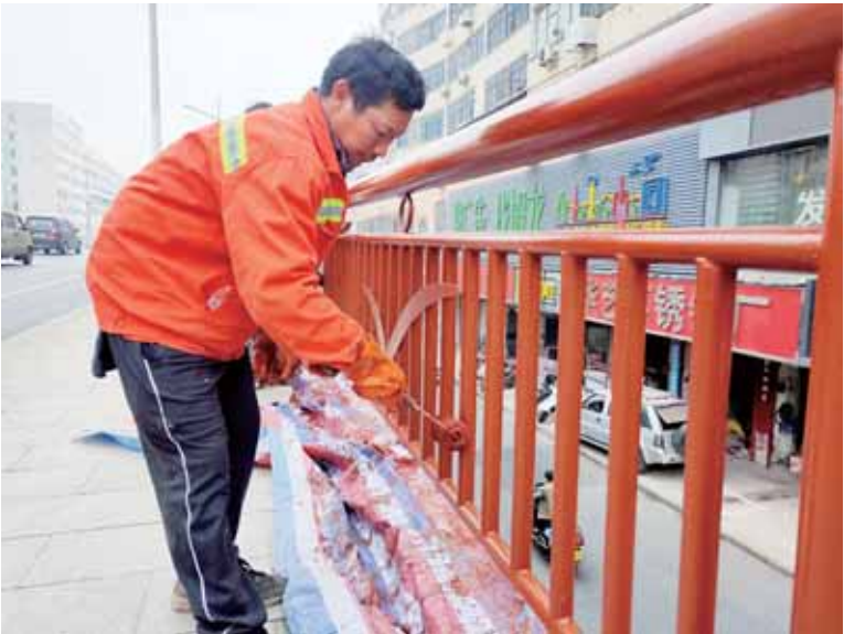
从12月15日起,我市对船山大桥护栏开展涂装作业,预计2020年元月上旬,船山大桥护栏将全部换上“新装”。 ■记者 胡亚华 摄
