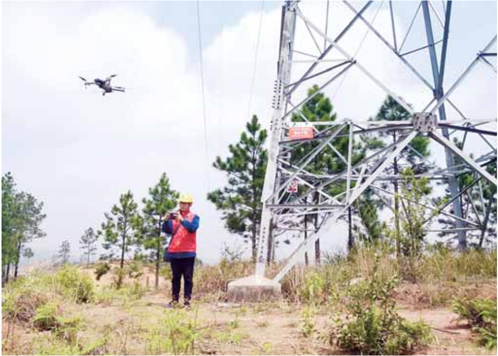
输电运检人员利用无人机高空视野优势进行山火火特巡
