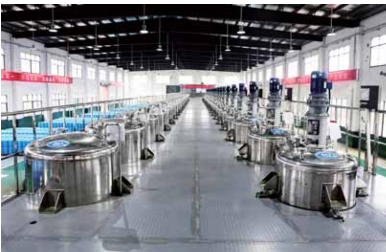
金裕环保科技有限公司自动化生产车间
