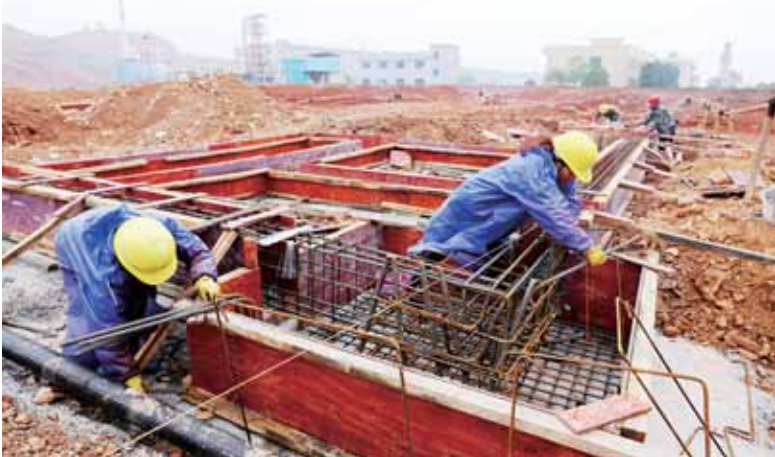
园区标准化厂房建设
