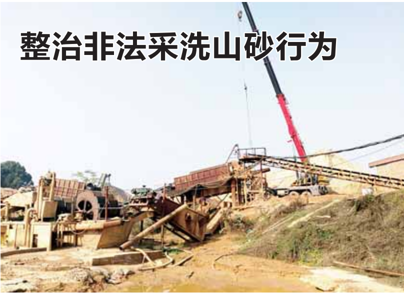
大吊车正在对一非法采洗山砂的砂场进行拆除作业
