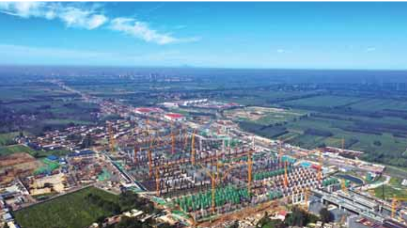
8 月 27 日无人机拍摄的建设中的雄安站。京雄城际铁路雄安站总建筑面积 47 万平方米，地上 3 层，地下 2 层，其中地下主体结构将于近期完成，即将转入地上主体结构施工。 ■新华社发
