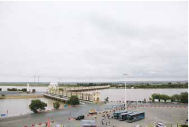
三盛公水利枢纽工程
