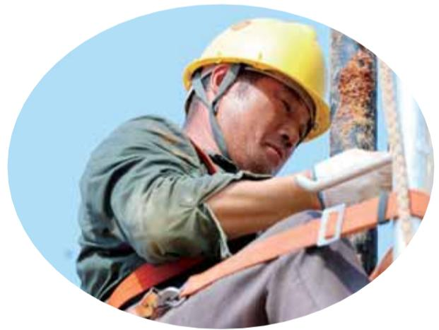
昨日上午 10 点,记者在 10KV 云南线电缆改架空线路工程现场看到,电力工人王于华头顶烈日进行电缆上杆搭头作业。据了解,该线路是从 110 千伏云集变电站到南岳机场,专供机场用电。此次改造从 7 月 24 日开始,预计今日完工,改造后将更好地保障机场供电。
