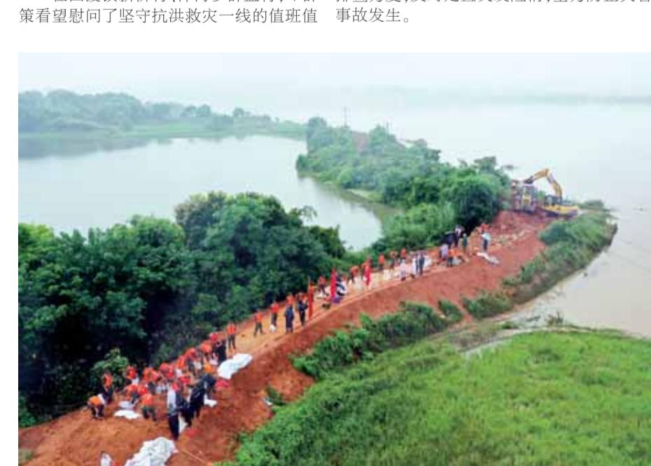
受新一轮强降雨影响，7月14日上午9时20分，衡东县霞流镇新拜朝村十组湘江干堤一段十五米长的坝体出现多处崩塌。接到汛情报告后，当地干部群众与武警衡阳支队官兵火速赶往现场，开展抢险救援。至昨晚9时20分许，武警官兵搬运200方沙土，打桩50个，圆满完成湘江干堤加固任务。(详见三版)
