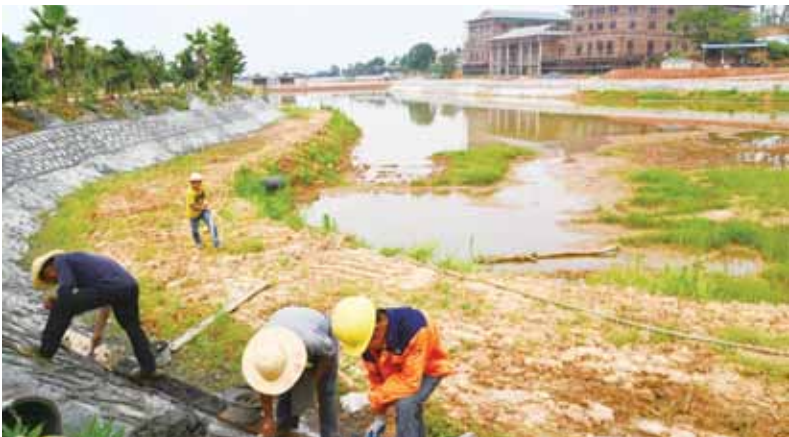
6月30日，几名施工人员在衡南县洪山镇扬名村旅游项目工地上施工。扬名村充分利用本地水域优势，开发乡村旅游，目前已引进以“村庄美、产业兴、农民富、环境优”为目标的东方唐韵项目，该项目将打造成集生态农业园区、文化旅游景区、田园康养社区于一体的新时代城乡共享的新家园。 记者 陈太仰 摄
