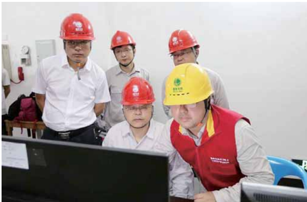
110 千伏清水变电站安全顺利完成“一键顺控”调试
