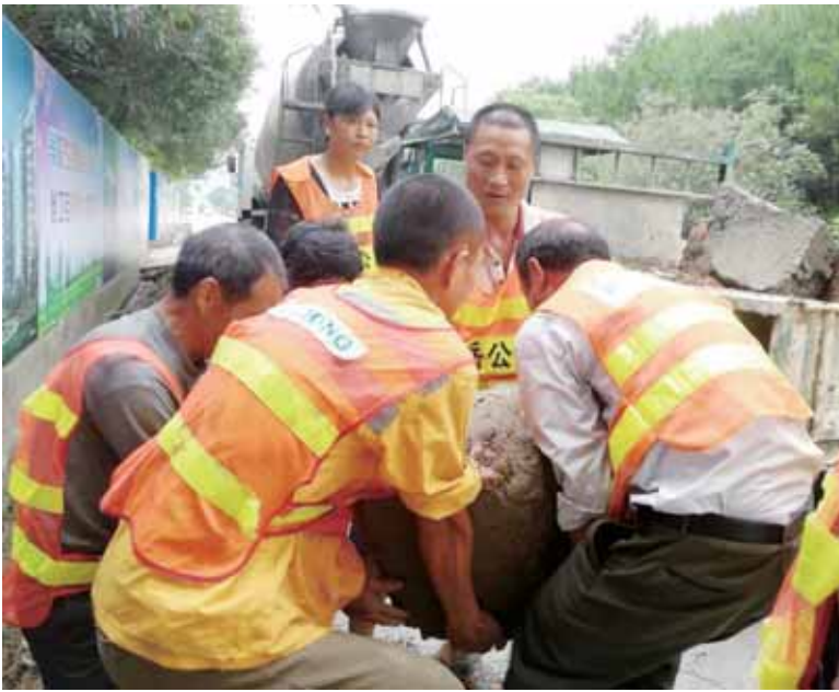
公路养护工作人员正在搬运建筑垃圾
