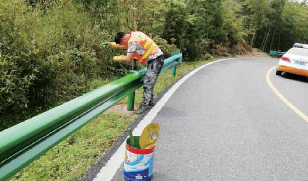
4月29日上午,在南岳衡山旅游区通往“十里茶乡”景点的 X023 公路(西方公路)边,几名公路施工人员正在对路侧的钢护栏进行刷油漆作业。近日,南岳区公路建设养护中心对旅游公路进行了一次“大整容”,实现了路况大提档。
