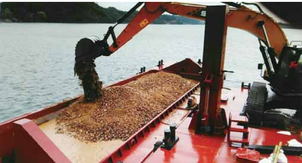
动用大型设备浚深拓宽航道
