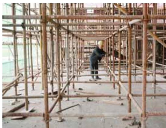
电商中心已建至7层,工作人员正在检查支模架
