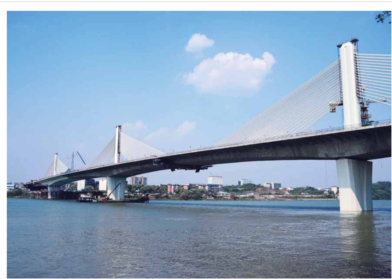
连日来，我市天气晴好，蓝天白云，河水清澈，如同一幅美丽画卷。图为大气宏伟的在建重点项目亚洲湘江大桥。 记者 王翟 摄
