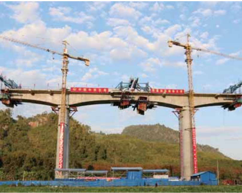
中铁五局承建的中老铁路首联连续梁合龙
