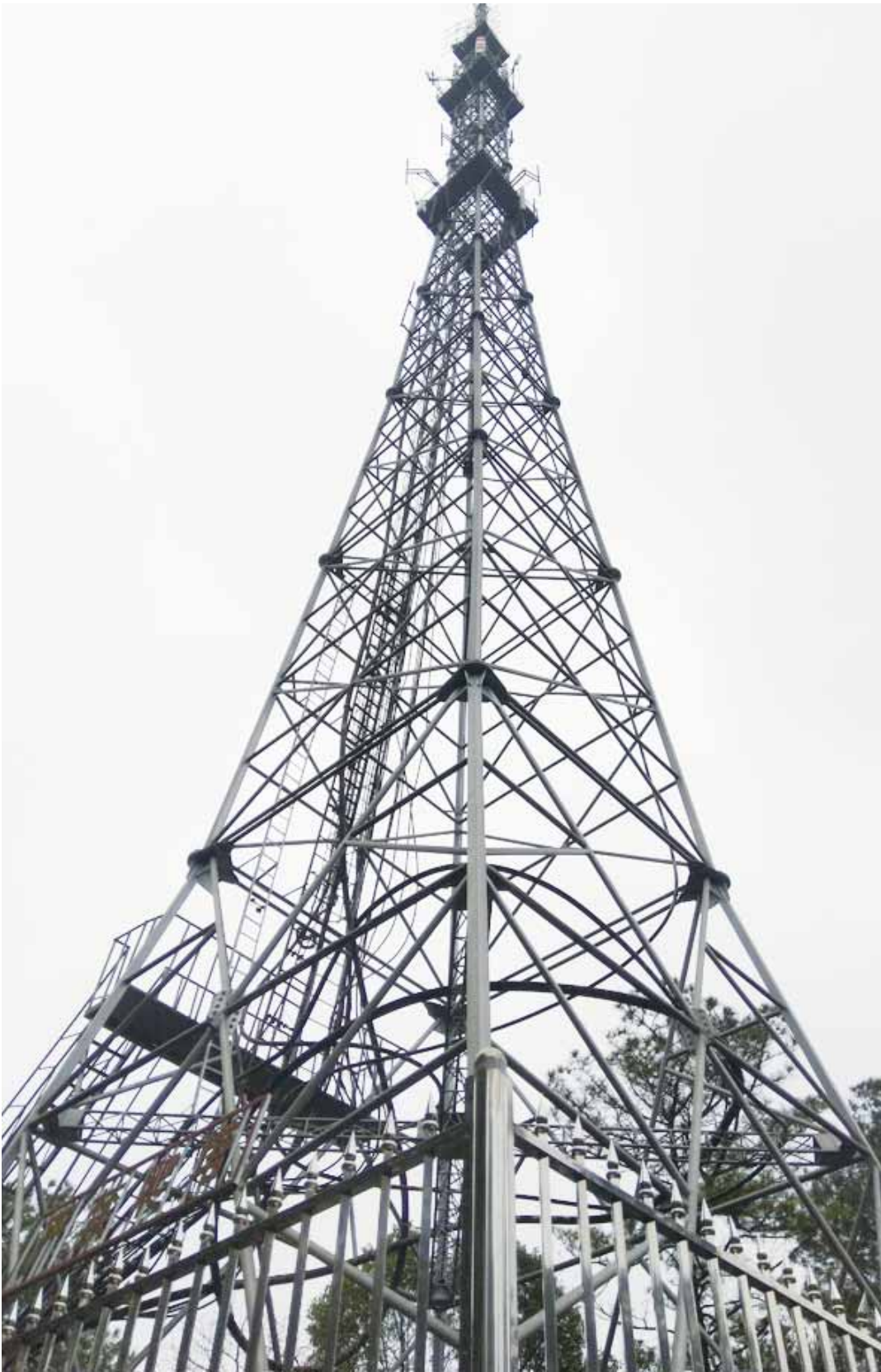
位于金泉峰上的广播电视信号塔直冲云霄
